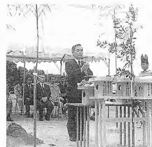
現地で行われた起工式
