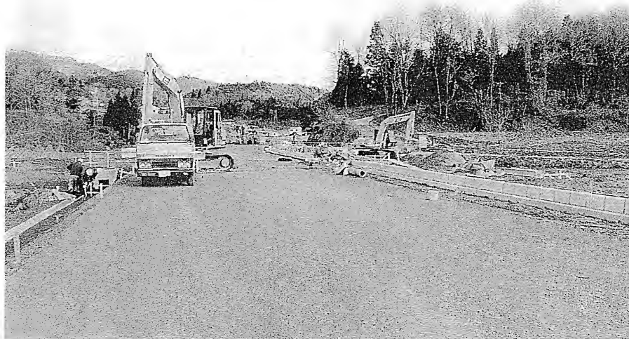
工事が進む西側アクセス道路 (岩法寺地内)
