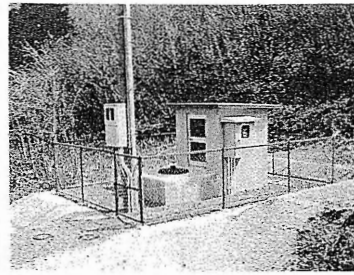
山小屋地区簡易給水施設
