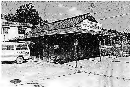
吉区集荷所を改装した玉川工場
