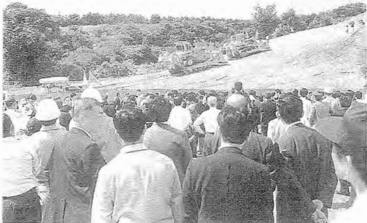
大勢の関係者が見守る中、工事がスタートする
