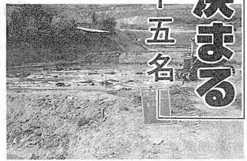
現在 基盤整備が進められている北須釜五升蔭地内
