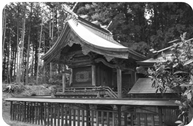
改修を終え輝く八幡神社本殿
