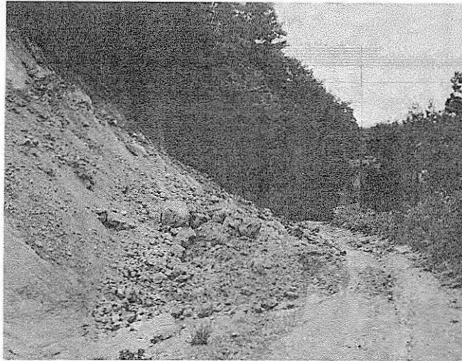
土砂崩れで道路が寸断
