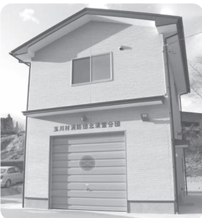
新築された北須釜分団屯所
