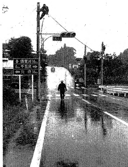
▲ 雨の中工事を急ぐ
