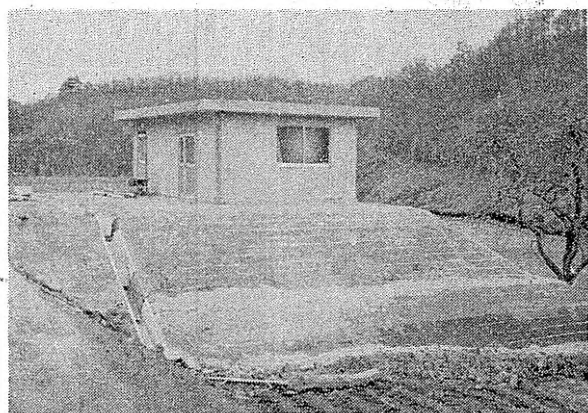
出来あがったポンプ室
