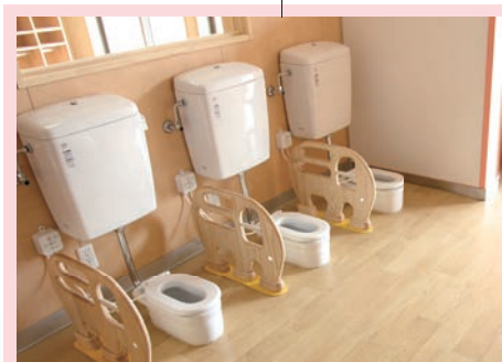
● 保育室には年齢にあったトイレが設置
