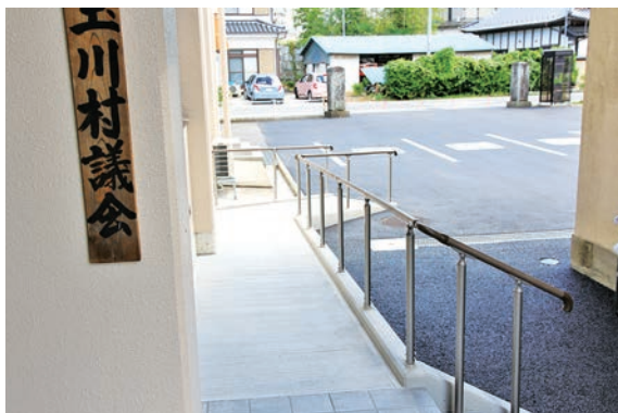
駐車場から北庁舎まで整備されたスロープ
