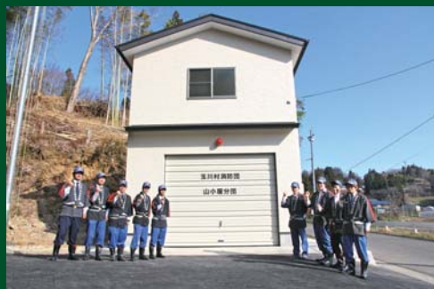
新しく建設された山小屋分団屯所
