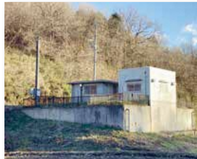
玉川村上水道丈田ポンプ場
