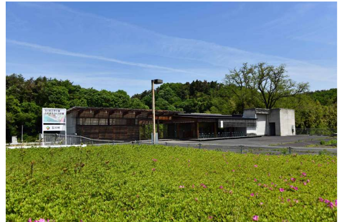
南側施設全景
