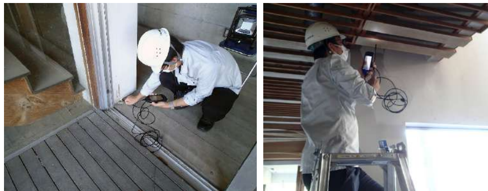
ファイバースコープを用いた目視困難箇所の確認
