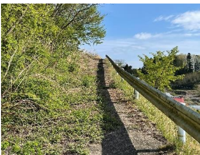
敷地東側の行き止まり路
