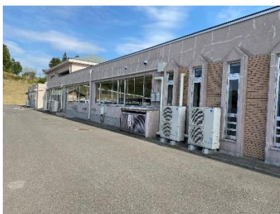
北側立面（校庭側）
