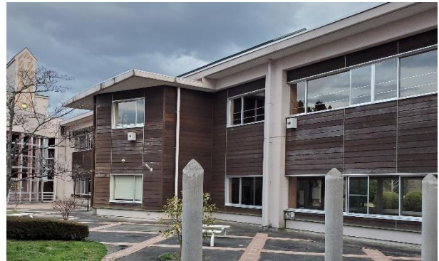
校舎外観（中庭側）
