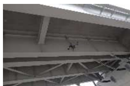
ドローンによる桁下の点検
