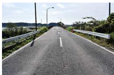
1号橋正面全景（奥側：成竜橋）
