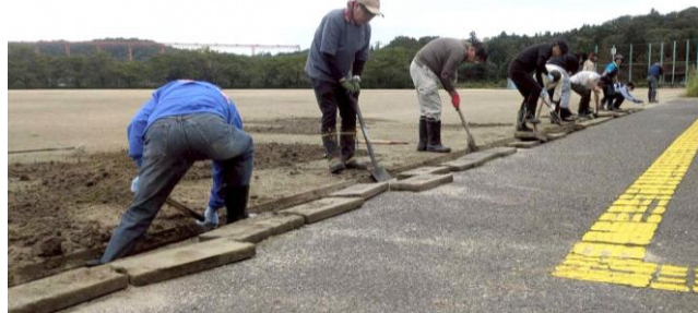
力をあわせて土砂上げ
