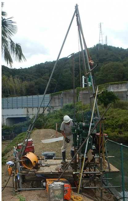
ボーリング作業状況
