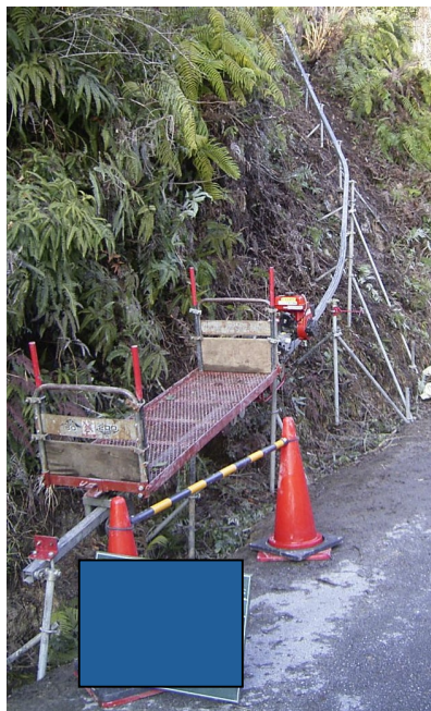
モノレール設置状況
