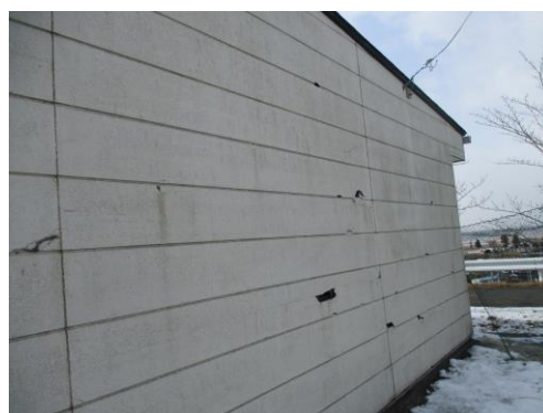
▼部室外壁のひび割れ
