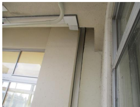
▼部室外壁のひび割れ
