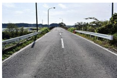
1号橋正面全景（奥側：成竜橋）
