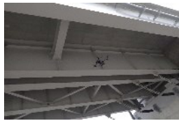
ドローンによる桁下の点検
