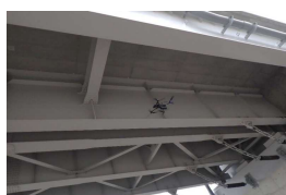
ドローンによる桁下の点検
