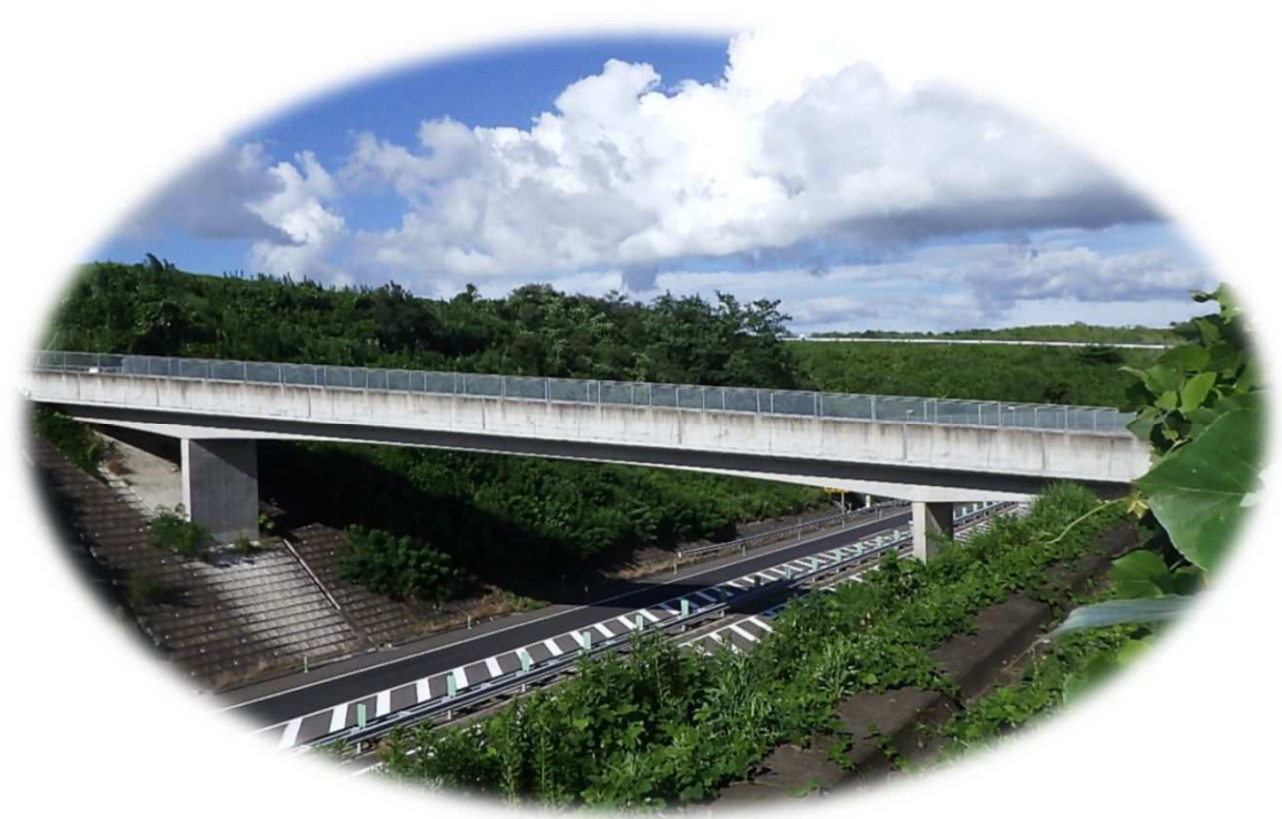
うさぎ跨道橋
