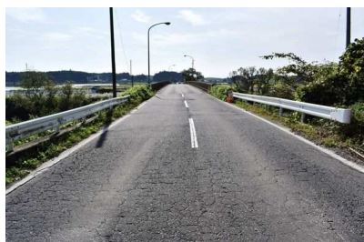
1号橋正面全景（奥側：成竜橋）
