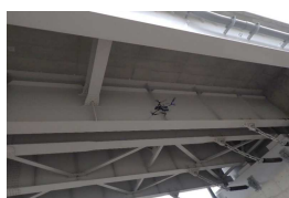
ドローンによる桁下の点検
