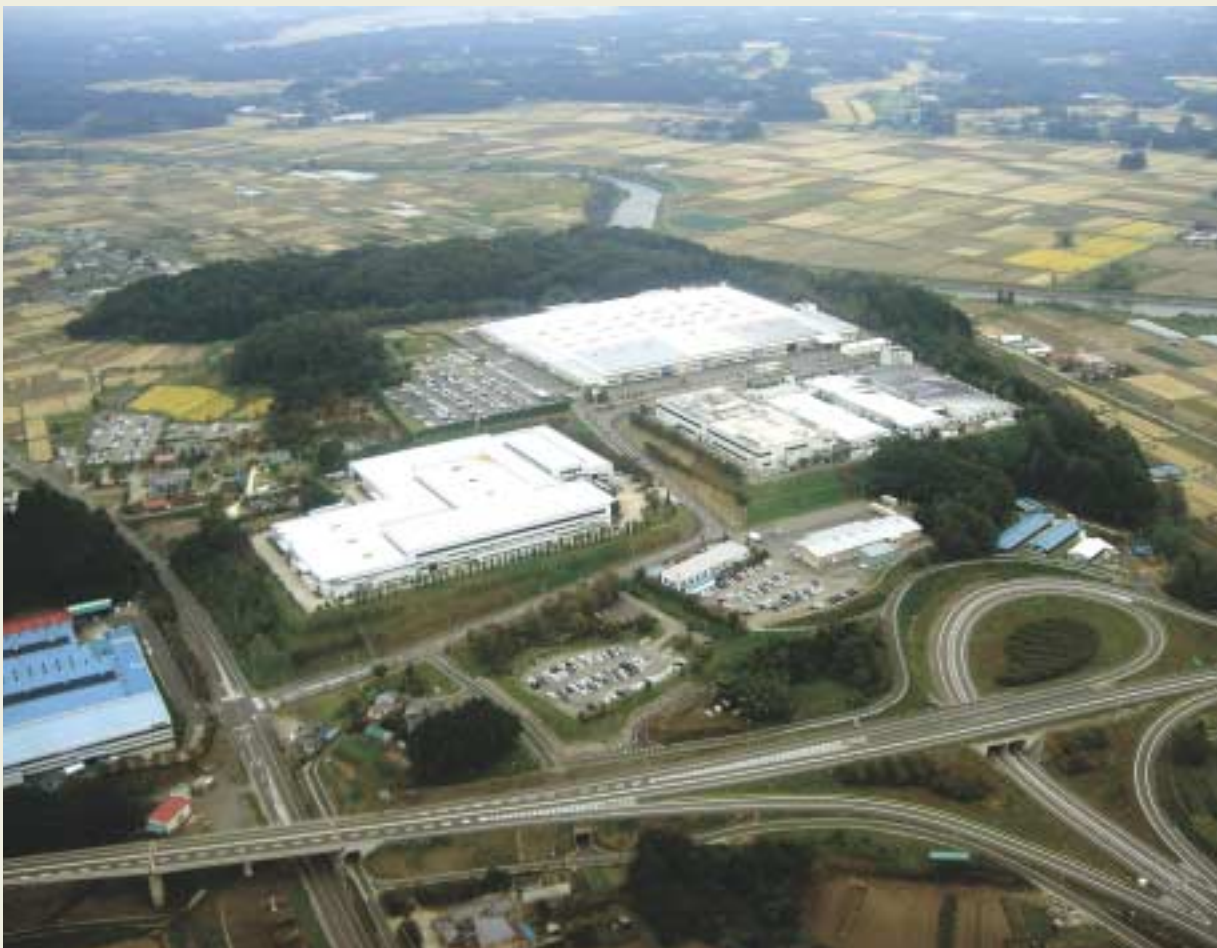
上空から見た玉川南工業団地
